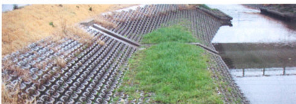
排水樋管改修工事
