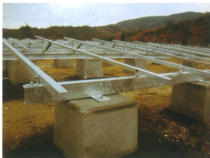
インサート固定状況
