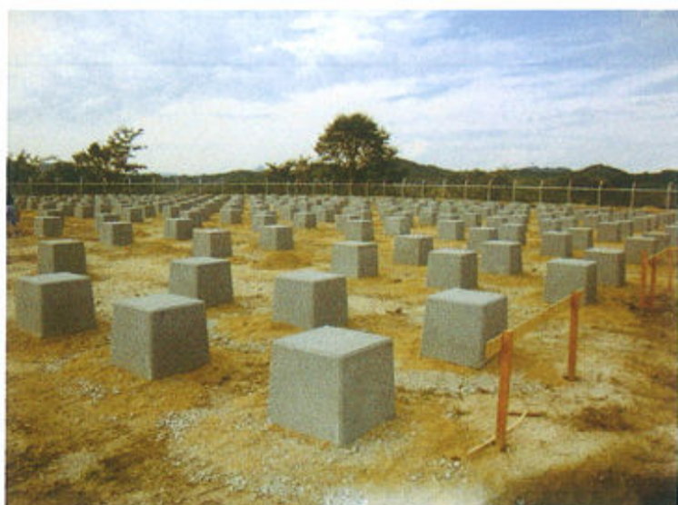
基礎ブロック設置状況
