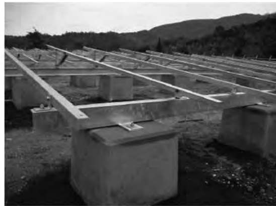
インサート固定状況
