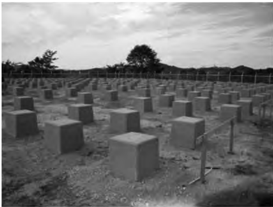
基礎ブロック設置状況
