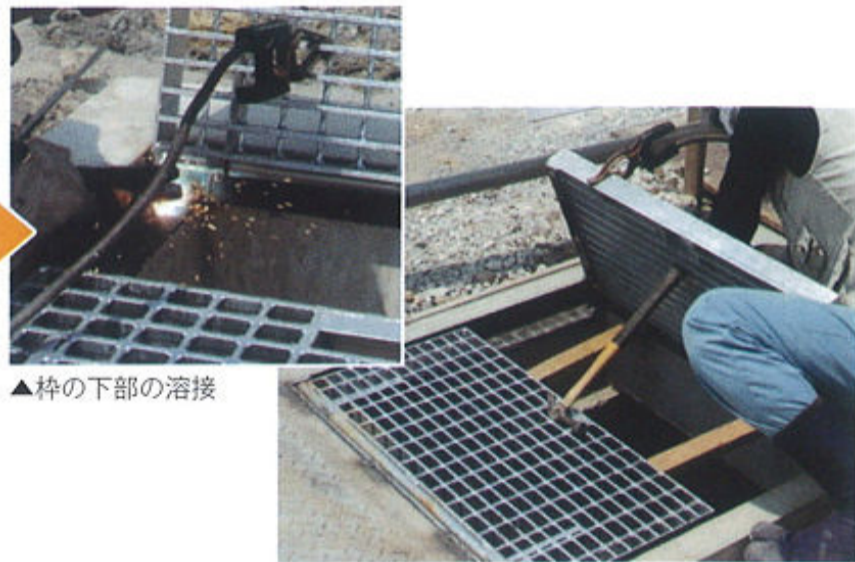
▲枠の上部の溶接（ハネがあるため木材で支える）
