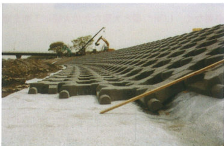
垂部施工状況
