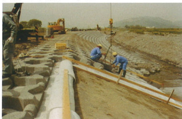
天端・法面部施工状況
