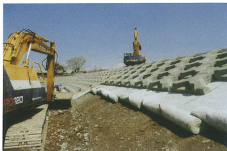
法面部施工状況
