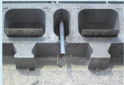
④水抜パイプはノックアウト部を割り欠き設置
