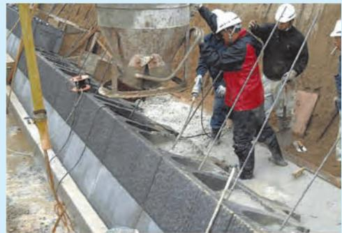
⑥胴込コンクリートを所定の胴込め部に打設
