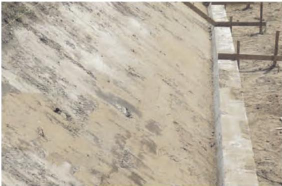
① 基礎コンクリート打設または基礎ブロックを敷設
