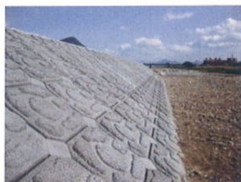
連結部着色コンクリート処理
